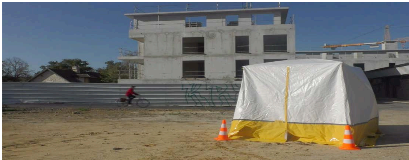
Tente de chantier © Nicoperrin
